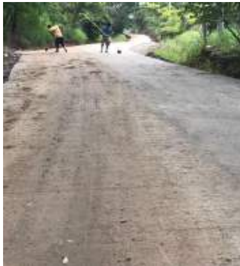
Fotografía 6. Limpieza previa a la entrega del proyecto, camino 1-016-114. Fuente: Alejandra Hernández Hidalgo
