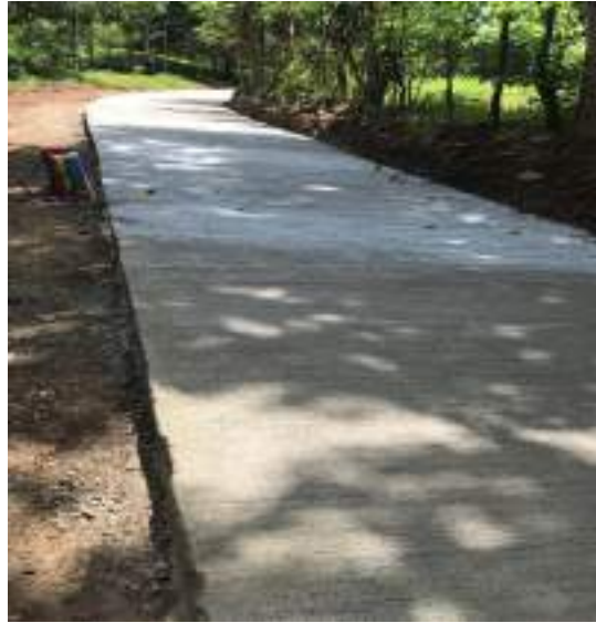
Fotografía 5. Aplicación del curador. KUREZ VOX WHITE, camino 1-016-114. Fuente: Alejandra Hernández Hidalgo
